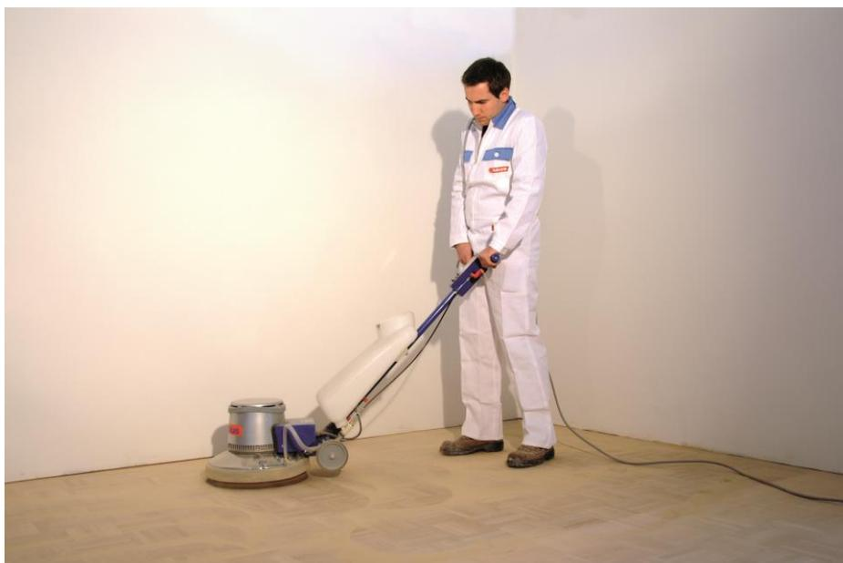
Подготовленное основание должно быть сухим и чистым. Обеспылить поверхность с помощью широкой кисти/ щетки/пылесоса или воздухом под давлением.
